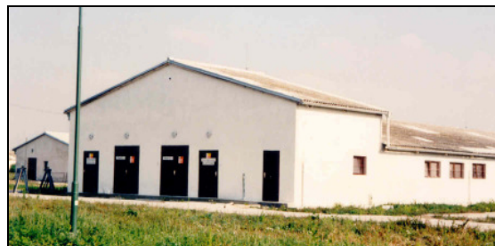
Obr. 7 Bývalá prípravňa krmiva prestavaná na trafostanicu (Jelka)
