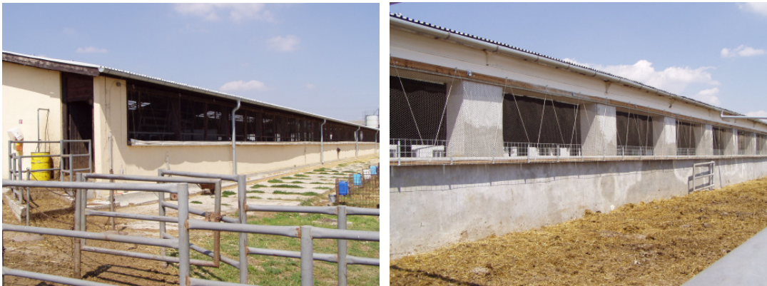
Obr.1 Pohľad na zrekonštruovaný objekt A (vľavo) s priebežnými bočnými vetracími otvormi a objekt B (vpravo) s čiastočným prebúraním okenných otvorov. V oboch prípadoch bola počas meraní v letnom období agrotexília úplne zvinutá dolu k parapetu, v zimnom období vytiahnutá do hornej pozície.
